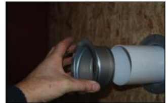
Putki asennetaan seinään
