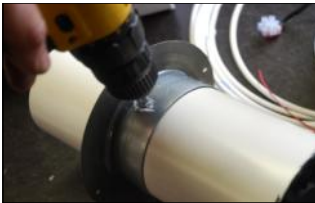
Seinä- / kattolaipan asennus
