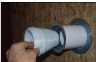
Suodatin laitetaan putkeen
