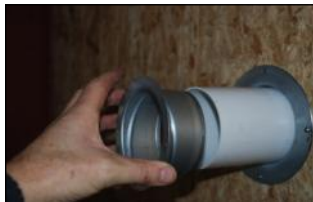
Tuloventtiilin laippa asennetaan,
