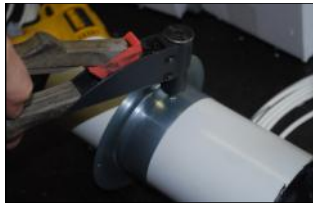
ja laipan kiinnitys putkeen.
