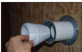
Filtret sätts på plats i röret
