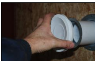
och inblåsningsventilen monteras.
