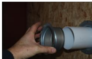
Röret monteras i väggen
