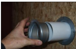
Inblåsningsventilens monteras,
